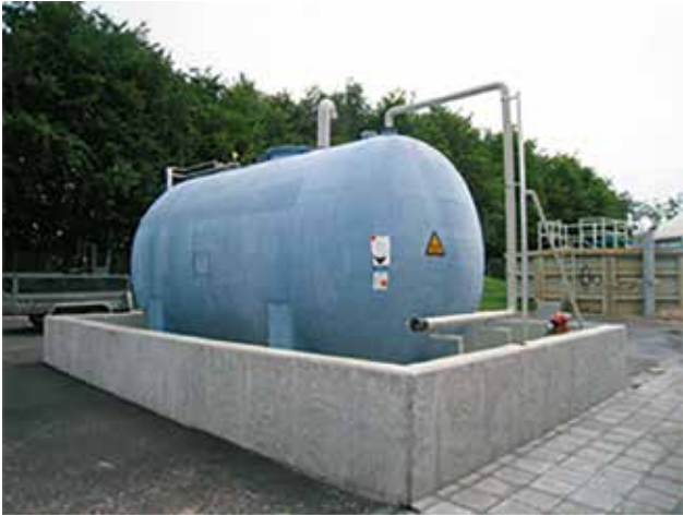
그림 5.6 염화철을 위한 저장탱크 설비. 사진 Kemira.
