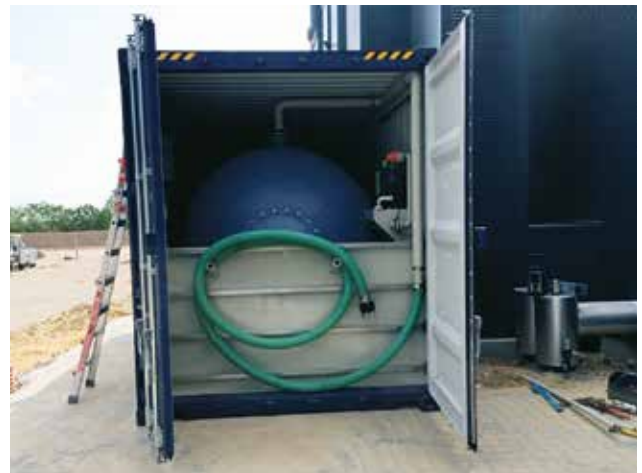
그림 5.7 컨테이너 솔루션인 저장 탱크 설비. 사진 Kemira.
