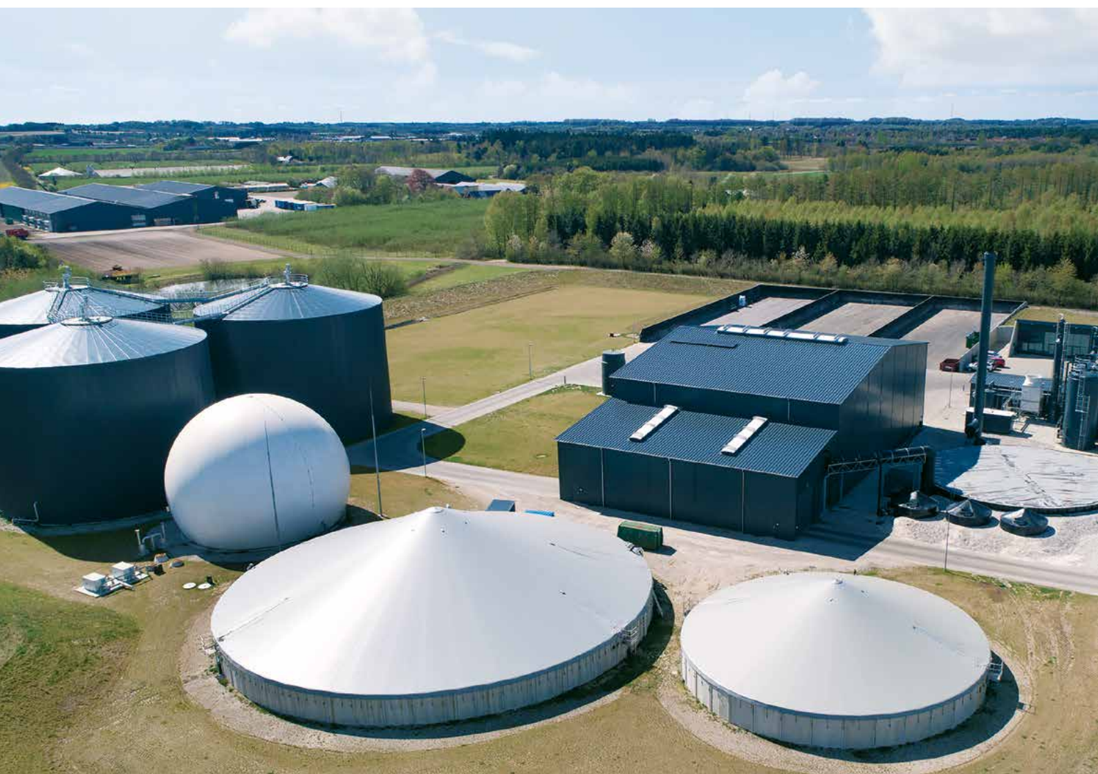
FIGURA 2.4 Planta de biogás ecológico de la empresa Månsson. FOTO Nature Energy
