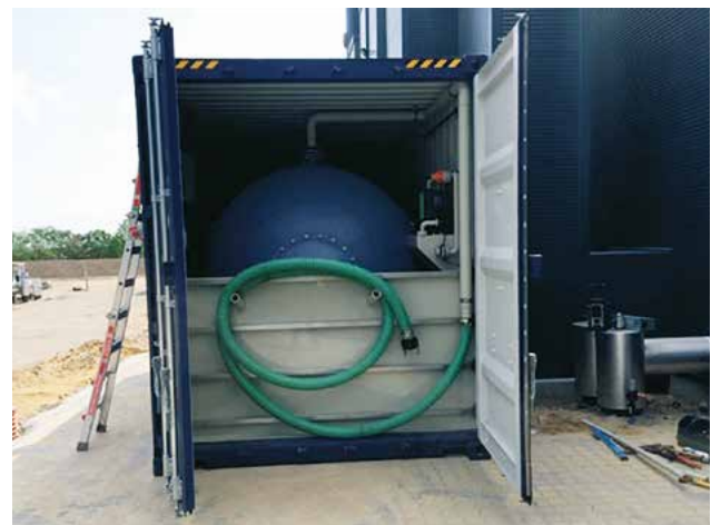
FIGURA 5.7 Instalación de tanques de almacenamiento en container. FOTO Kemira.
