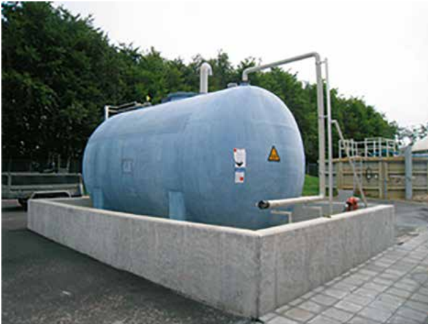
FIGURA 5.6 Instalación del tanque de almacenamiento de cloruro de hierro. FOTO Kemira.
